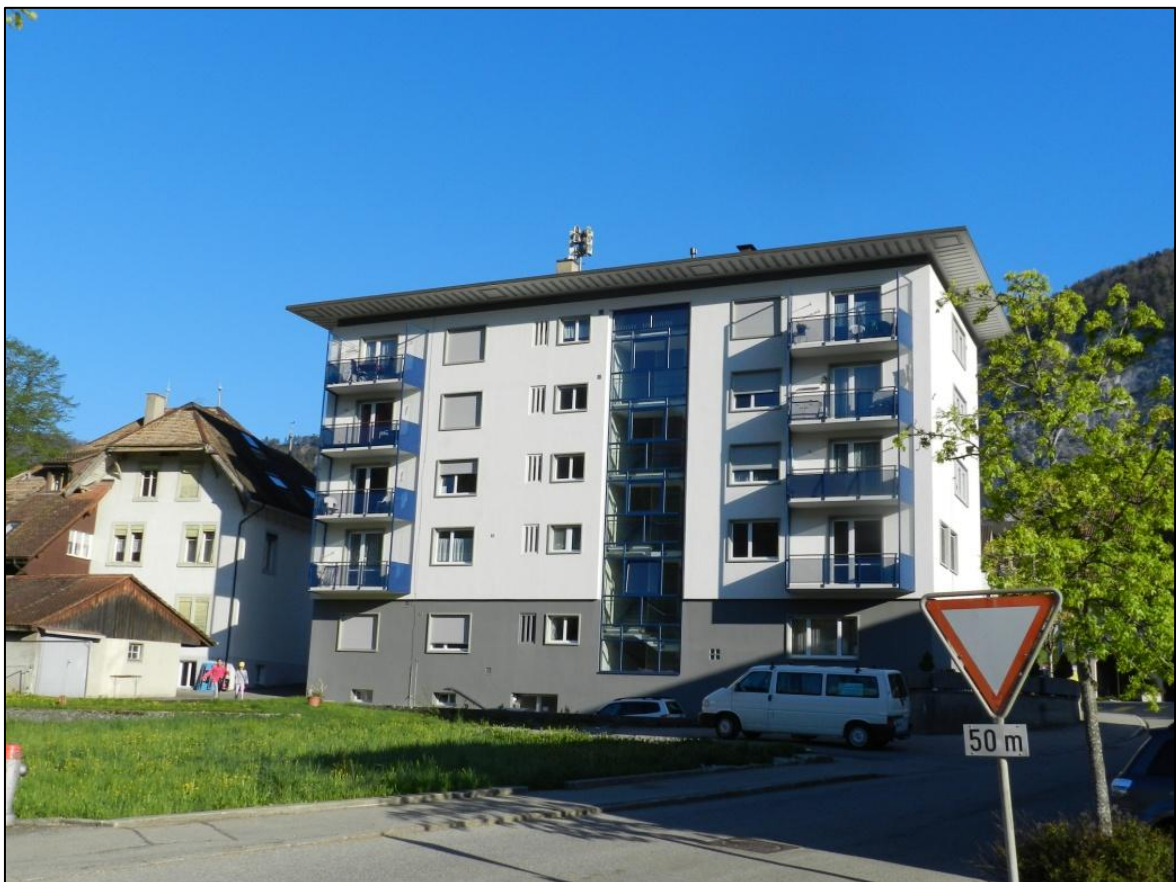
Abbildung 11 Thalhof – markantes Gebäude im Dorfzentrum
